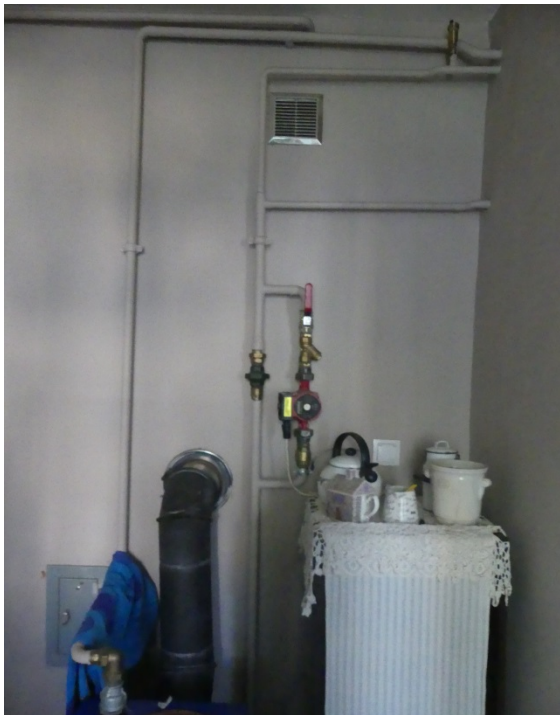
Zdj.1 Widok na przyłączenie pieca do komina w mieszkaniu nr 1
