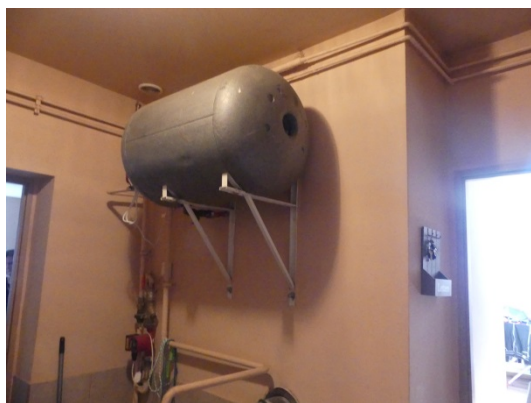
Zdj.23 Widok na zainstalowany bojler mieszkanie nr 8
