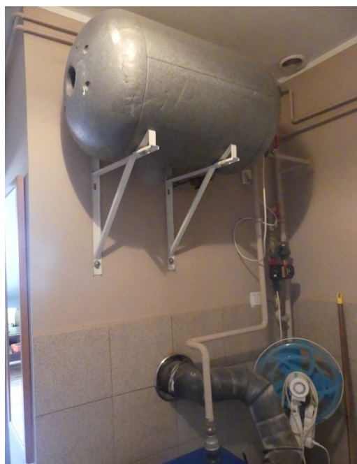
Zdj.20 Widok na zainstalowany bojler mieszkanie nr 7
